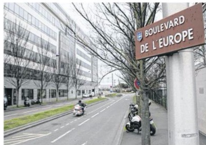
Les travaux de prolongement du boulevard de l'Europe pourraient démarrer en 2022.
